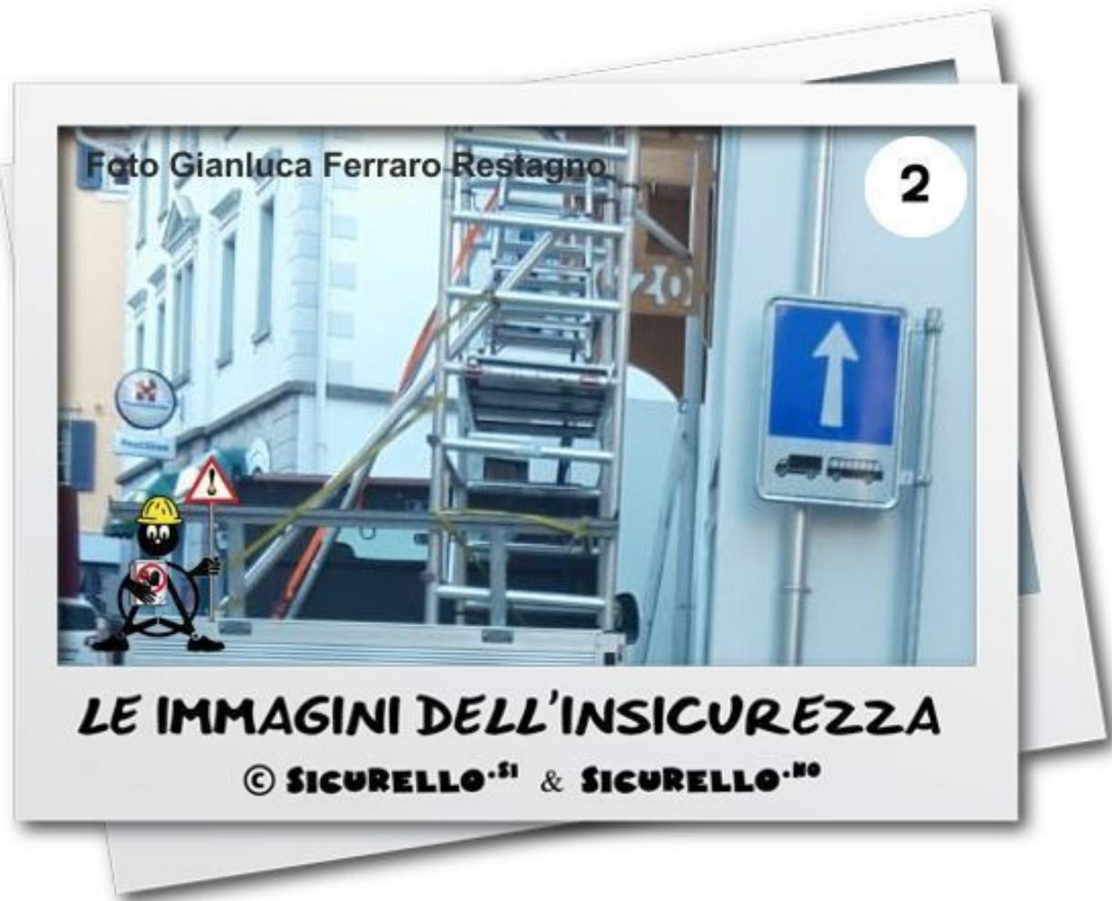
Sicuramente la situazione non è delle più sicure, basta vedere le modalità di "bloccaggio" del ponte con fasce legate direttamente al supporto porta-materiali posteriore del mezzo e delle controventature che "spingono" verso la sponda sponda laterale.
