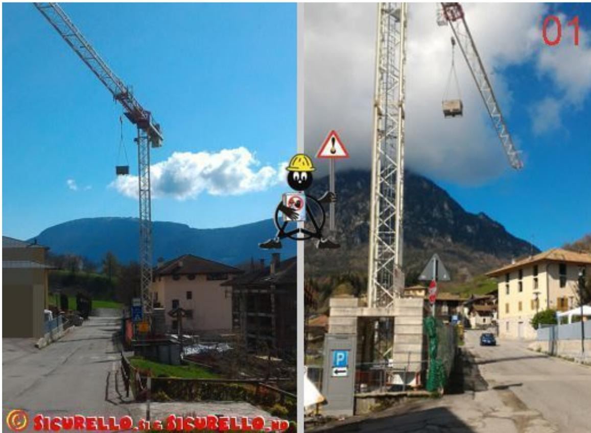
Peccato che nell'esempio della foto, in considerazione del posizionamento della gru a ridosso della pubblica via e della necessità di lasciare "sfrenata" la rotazione del braccio della gru stessa, la rotazione del braccio, causata dal vento, porti il container a posizionarsi sulla proiezione del marciapiede attiguo al cantiere.
