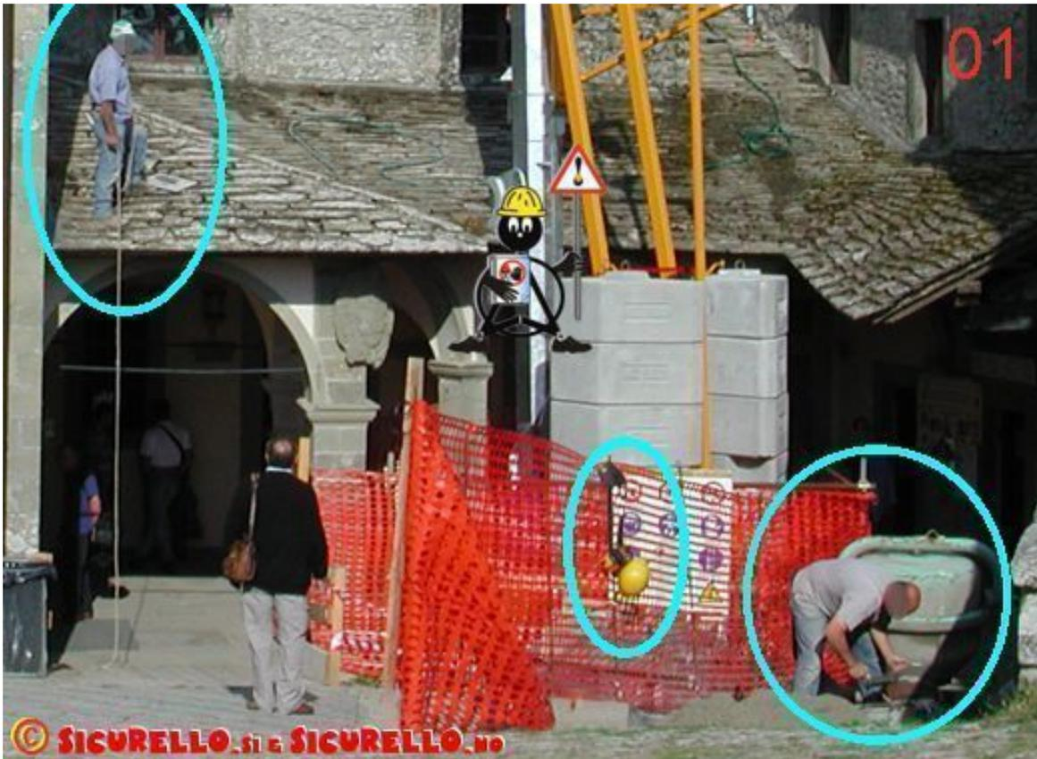
A prima vista sembrava la classica situazione che vede un lavoratore che sta eseguendo la propria attività con un elevato rischio di caduta dall'alto, in quanto posizionato sulla copertura di un porticato senza l'adozione di alcuna misura di protezione anticaduta, sia essa collettiva (come prescriverebbe la norma) od almeno individuale.
