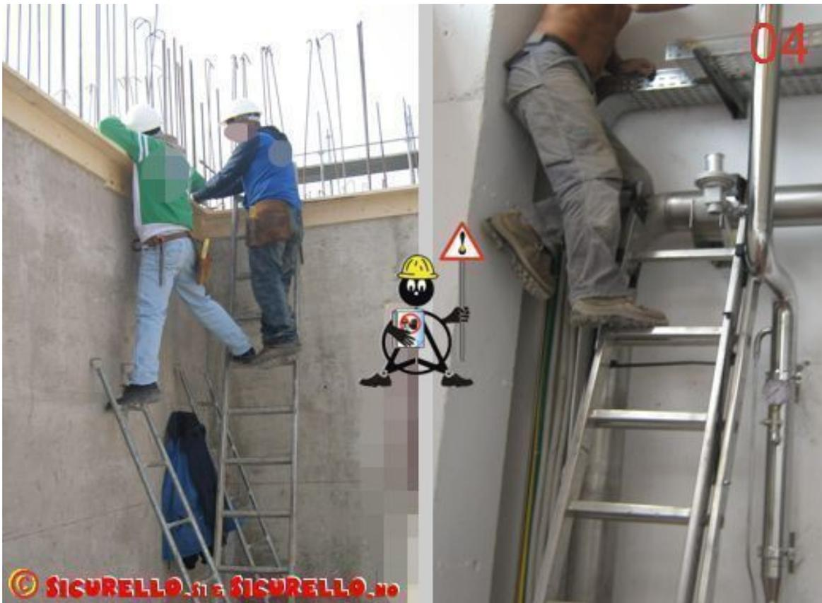
Sia nella foto 01 che nella parte a sinistra della foto 04 (quella a sinistra) vediamo inoltre l'operaio che posiziona i piedi su due scale differenti, operazione anch'essa ad alto rischio.
