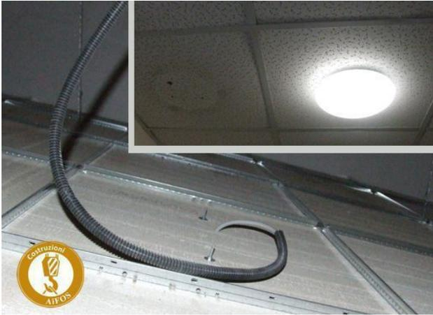
*Figura 3 - Esempio di lampada montata in modo inidoneo ovvero direttamente sul pannello del controsoffitto. Da notare sul pannello di sinistra i segni inequivocabili di un precedente posizionamento del corpo illuminante. Lo spostamento della lampada era stato effettuato in quanto il pannello iniziava a cedere.*
