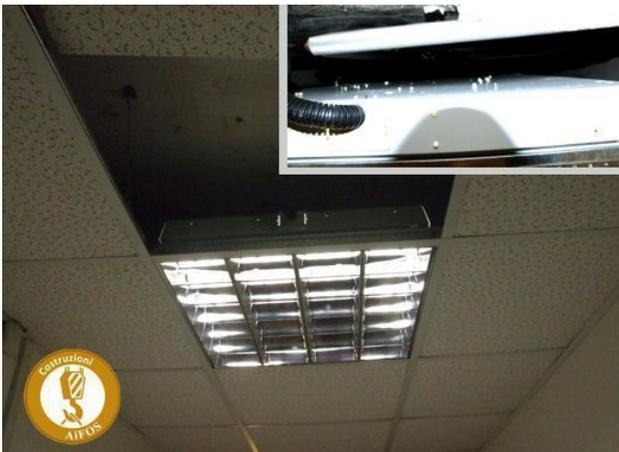
*Figura 4 ? Esempio di montaggio corpo illuminante senza pendenza, ovvero montato direttamente sulla struttura del controsoffitto e pertanto gravante su di essa.*
