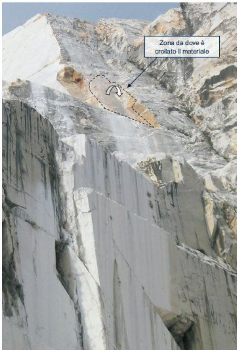
Foto 2 - area di distacco del materiale franato
