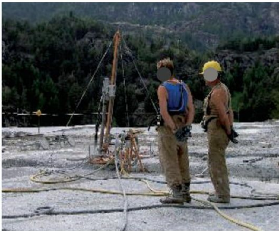
Figura 6.1 - Perforazione della bancata
