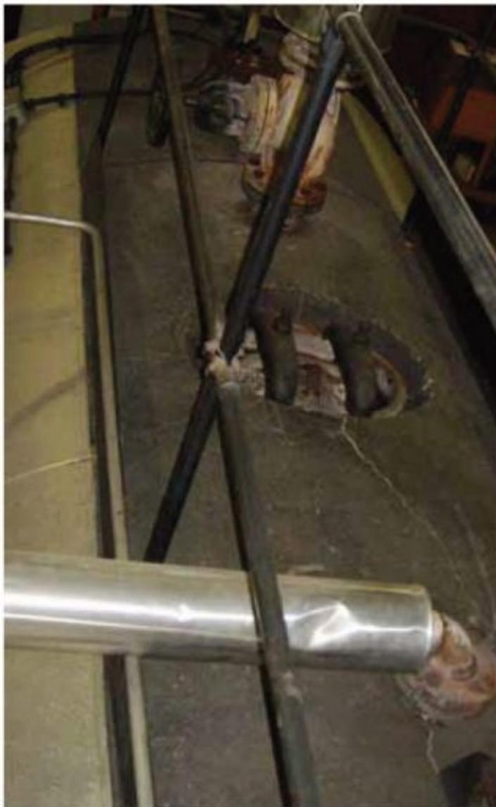
(Figura 3 - passo d'uomo 32x42 generatore di vapore
