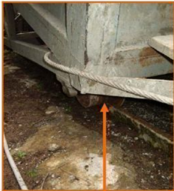
Particolare delle ruote del carrello che poggiano su una rotaia con profilo inadeguato in relazione alla distanza ruota - terreno, così da favorire il possibile deragliamento
