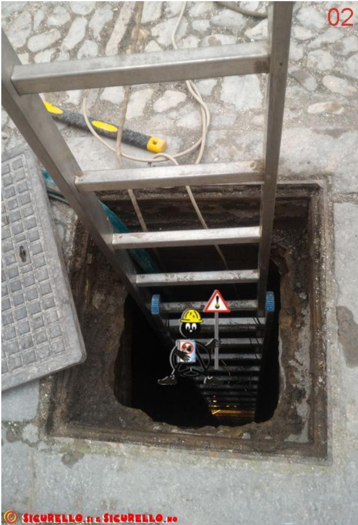
L'idea è quella che il pozzetto sia di ridotte dimensioni e l'operaio stia effettuando attività non a rischio, ma invece avvicinandosi si scopre che non di un pozzetto si tratta, ma di una " vasca" con dimensioni e profondità certamente rilevanti e le cui caratteristiche possono rientrare a pieno titolo in quelle di " spazio confinato" in quanto:
