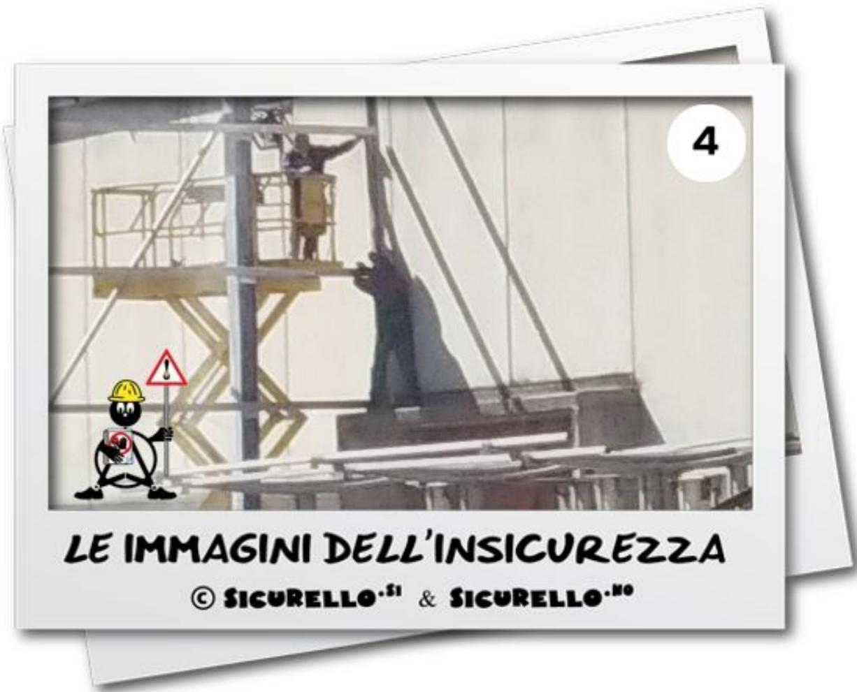
Ma forse della propria sicurezza a questi operai, al loro preposto, al loro datore di lavoro ed al coordinatore per la sicurezza del cantiere, proprio non interessa nulla. Anche perché la totale assenza di ogni tipo di dispositivo di protezione individuale, l'assenza di ogni tipo di protezione collettiva e l'assenza di opere provvisoria di sicurezza sono certamente un sintomo di totale indifferenza, passività e forse anche di notevole menefreghismo.
