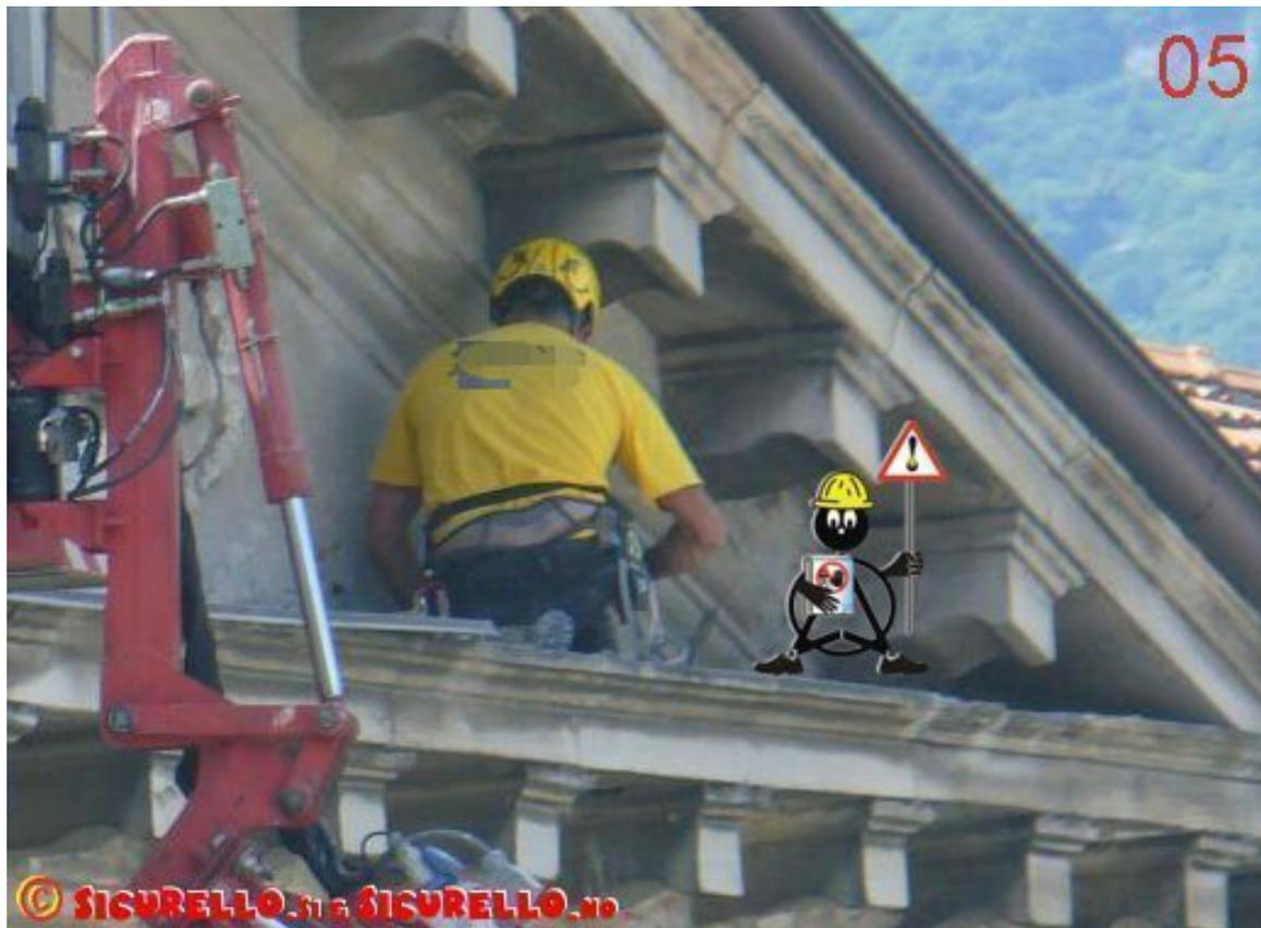
Il DPI anticaduta è indossato dall'operatore che rimane nella navicella, mentre l'altro che esegue l'attività in uno spazio particolarmente complesso (cornicione molto stretto, necessità di assumere una posizione non ideale, rischio di urto contro gli elementi lapidei superiori, ...) e con elevatissimo rischio di caduta dall'alto, indossa il solo elmetto di protezione.
