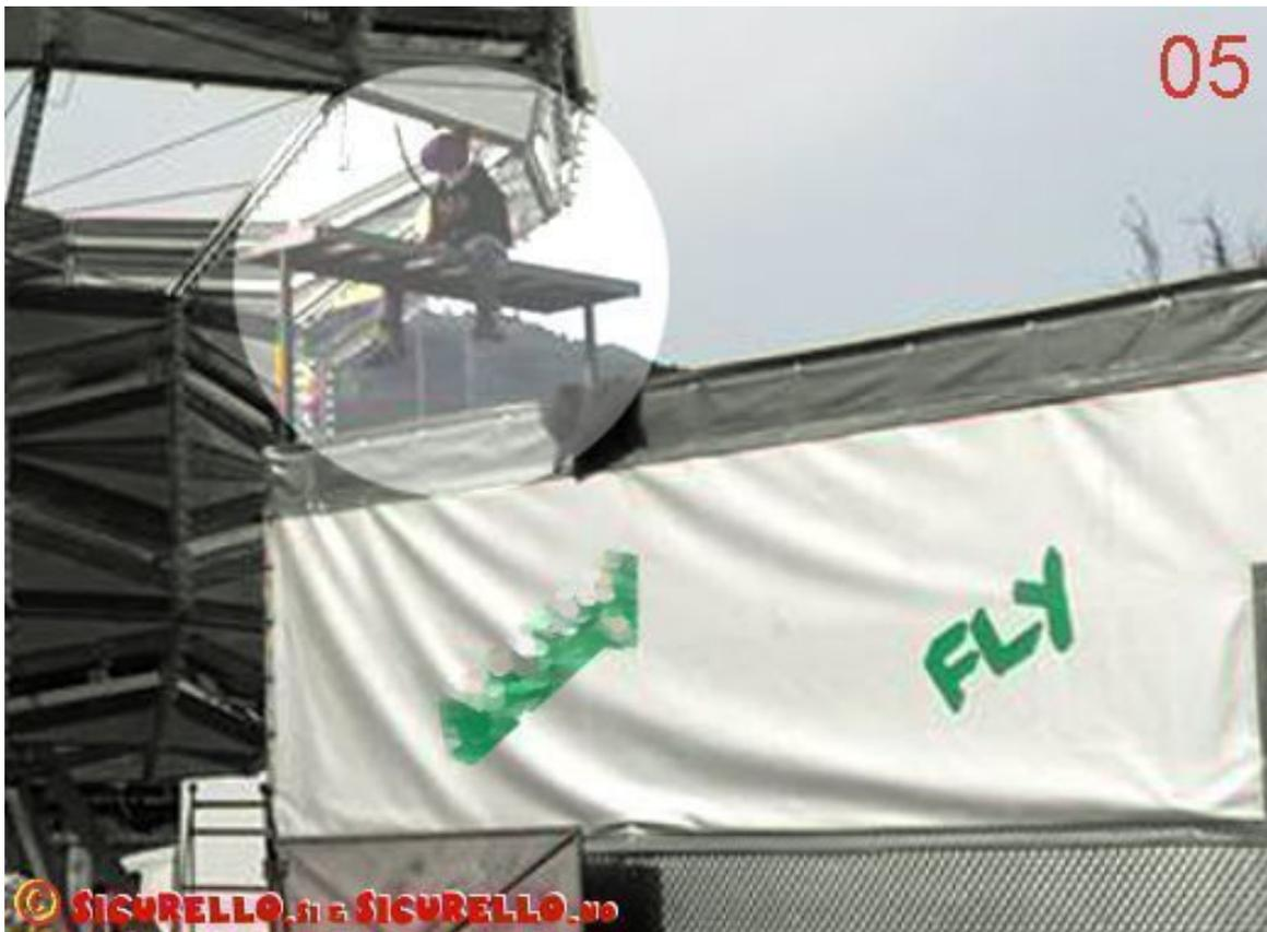
Per la **seconda (foto 04, 05)** l'assemblaggio viene eseguito da un operatore appollaiato su una piattaforma collegata alla centinatura del camion. Supporto precario, struttura apparentemente molto debole, nessuna protezione.
