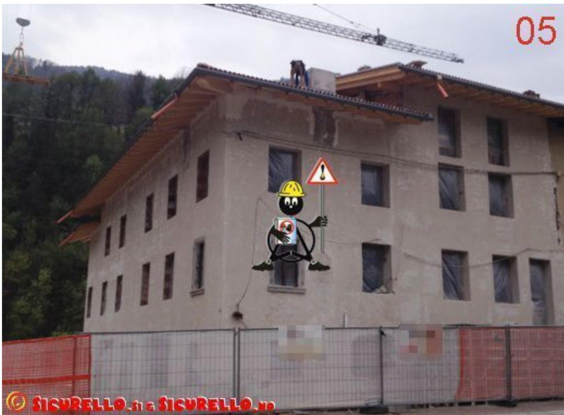
Ed infine visto che la lavorazione viene effettuata senza la presenza di alcun tipo di protezione, sia essa collettiva, sia essa individuale, qualcuno si è posto il problema di come verranno realizzate - in sicurezza - le finiture (ad esempio dei camini), oppure NO?
