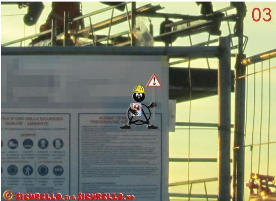
Dalle immagini è evidente che il trabattello non risulta essere idoneo all'attività svolta in quanto l'ultimo impalcato risulta montato ad una quota tale che non garantisce la presenza di un parapetto perimetrale di almeno un metro ed inoltre il lavoratore per raggiungere i punti di lavoro deve posizionarsi sugli elementi di parapetto presenti, con un elevatissimo rischio di caduta dall'alto.
