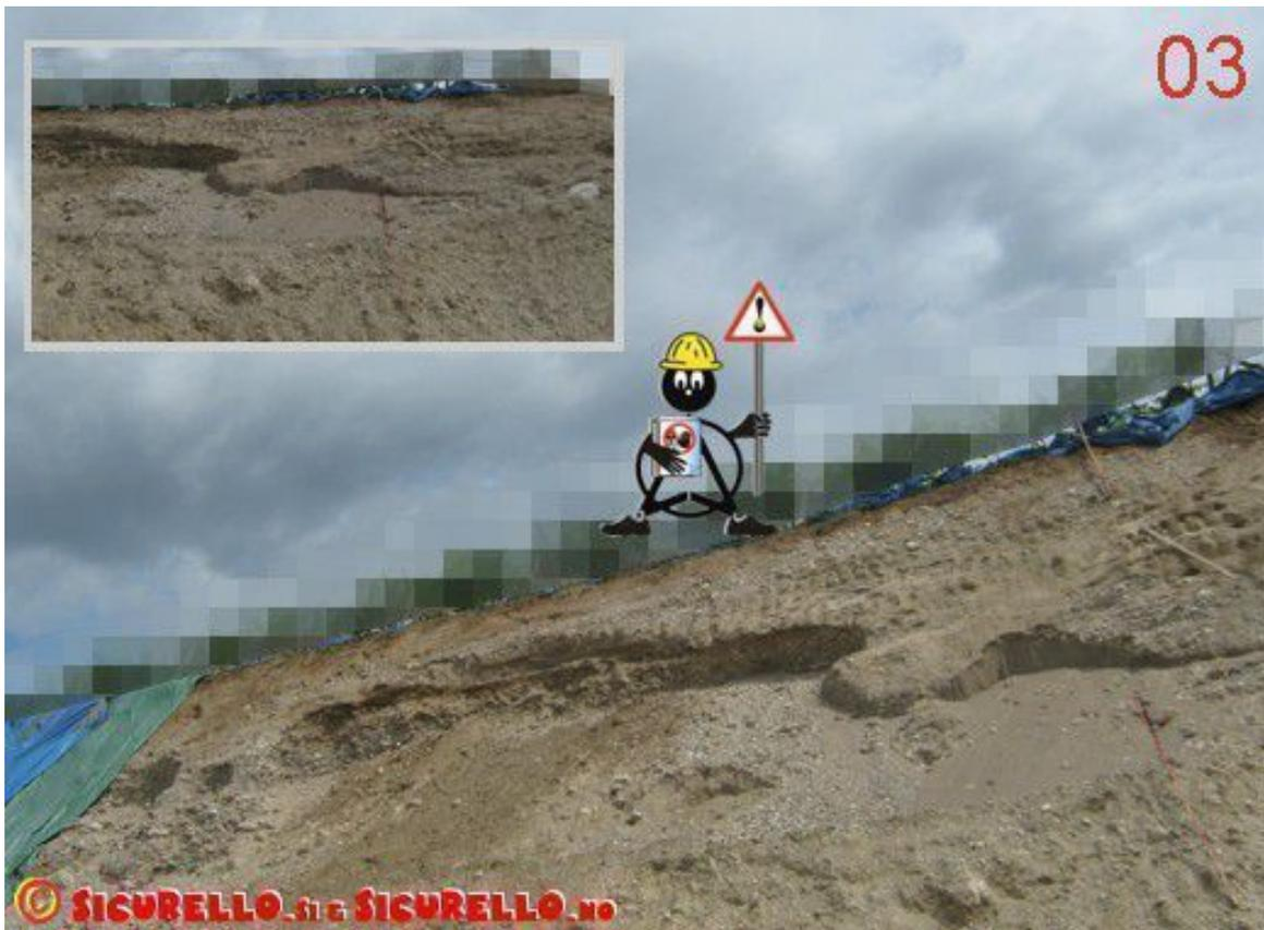
Un ulteriore rilievo riguarda la parte destra della foto 02. In questo caso oltre al problema relativo alle pareti dello scavo, vi sono problemi pure per la messa in opera del pannello-cassero delle murature: gli spazi di lavoro per gli addetti non sono certamente idonei ad eseguire l'attività in sicurezza.
