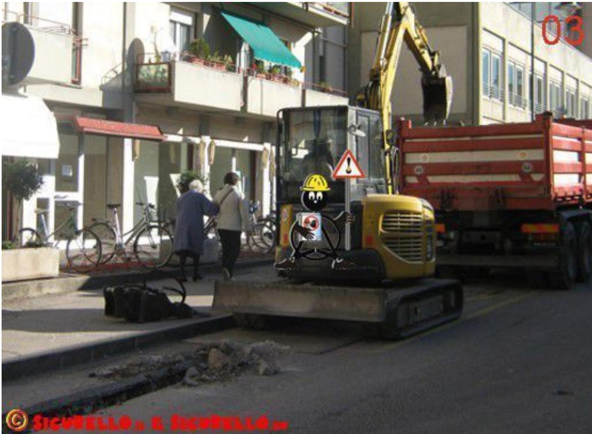
La seconda situazione riguarda invece gli autisti dei mezzi che vengono impiegati per il trasporto dei materiali scavati. La necessità di verifica che il carico sia correttamente costipato ed evitarne la perdita durante il trasporto, fa sì che l'autista salga sul cassone del mezzo per controllare.
