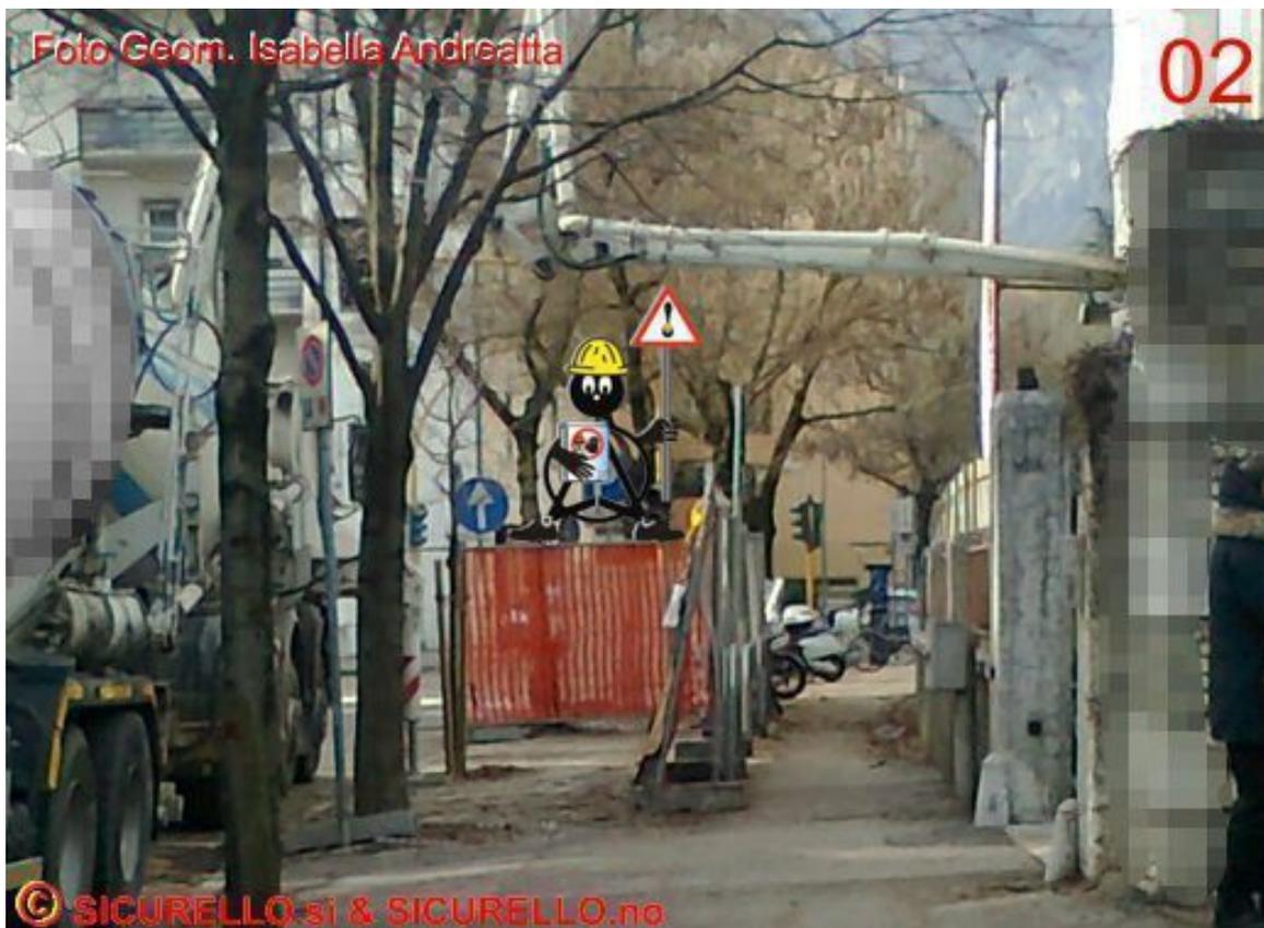
Dalle immagini è evidente che il braccio della betonpompa sorvola il marciapiede e non risulta presente alcuna protezione (attiva o passiva) dei pedoni che abbiano a passare sotto di esso, ricordiamo che esiste il divieto di transito o sosta nel raggio d'azione del braccio della pompa stessa.
