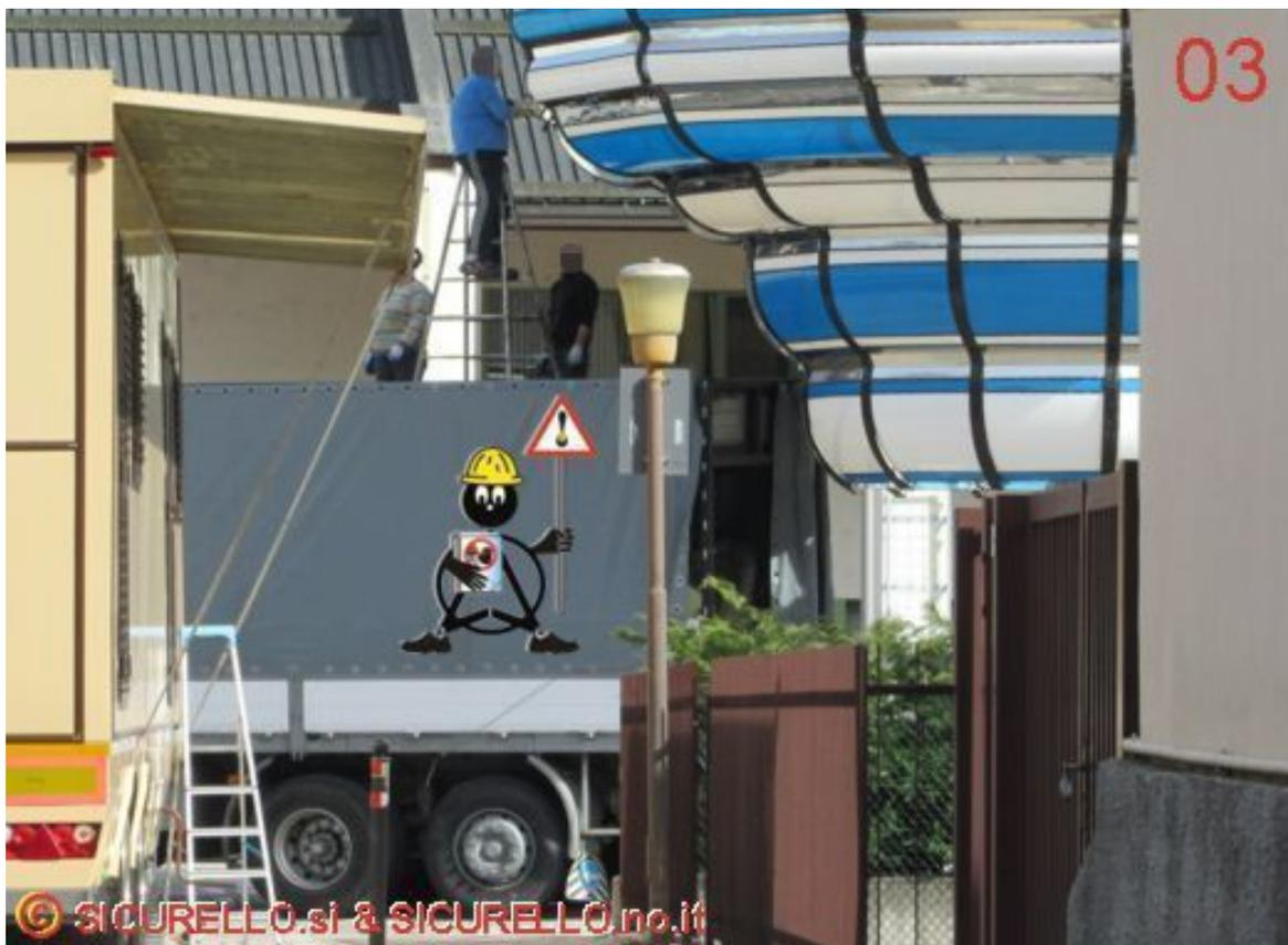
Foto 01 ? 02 - 03: Vedendo la scena ho inizialmente pensato che la prospettiva fosse ingannevole e la scala su cui era (scorrettamente) posizionato l'operatore fosse piazzata su una struttura idonea, ma poi guardando l'attività da punti differenti la sensazione iniziale veniva confermata: la scala era appoggiata su uno dei piani di carico piazzato sulla sommità del cassone.
