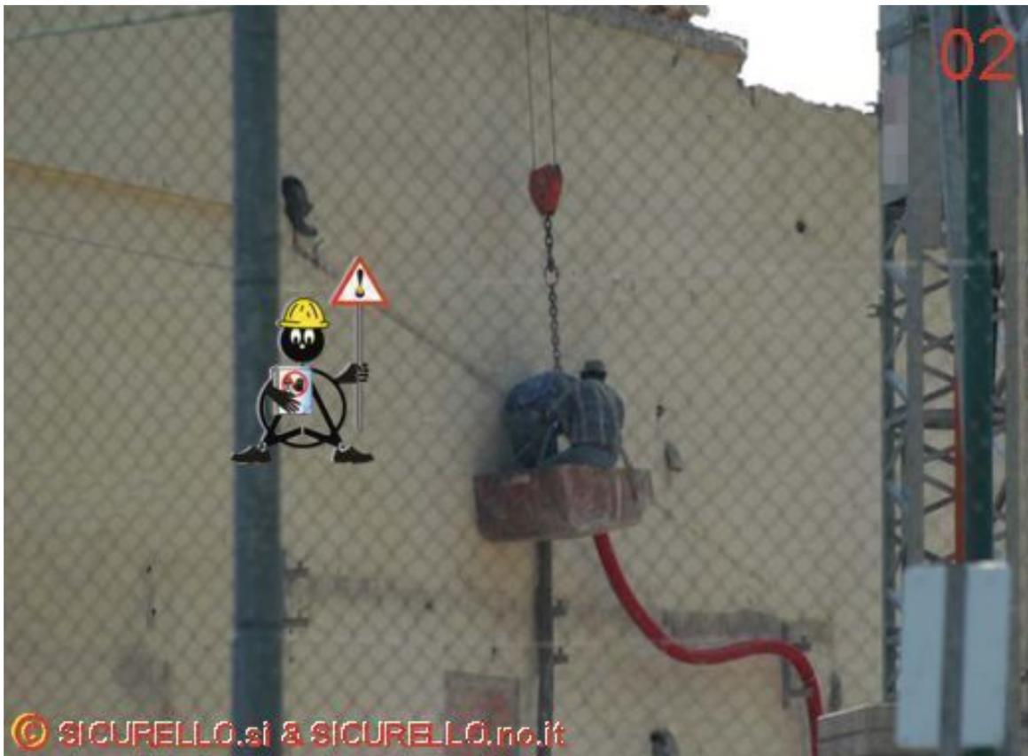
Ed ecco allora due operai portati in quota all'interno di una benna della gru di cantiere. Un'operazione che mette i brividi e che non può trovare giustificazione alcuna.
