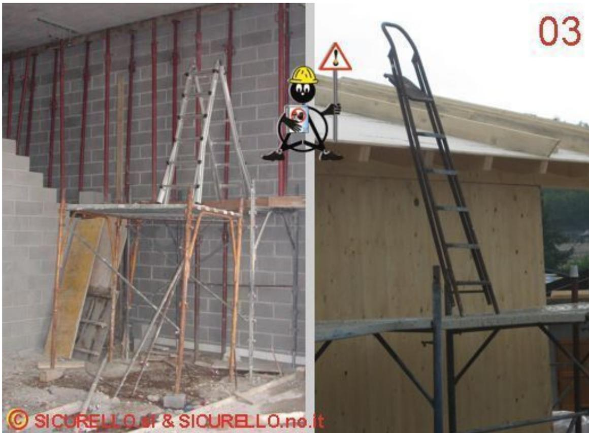
Foto 03: Il ponte a telai diventa la piattaforma per appoggiare una scala, il rischio caduta dall'alto è in agguato.
