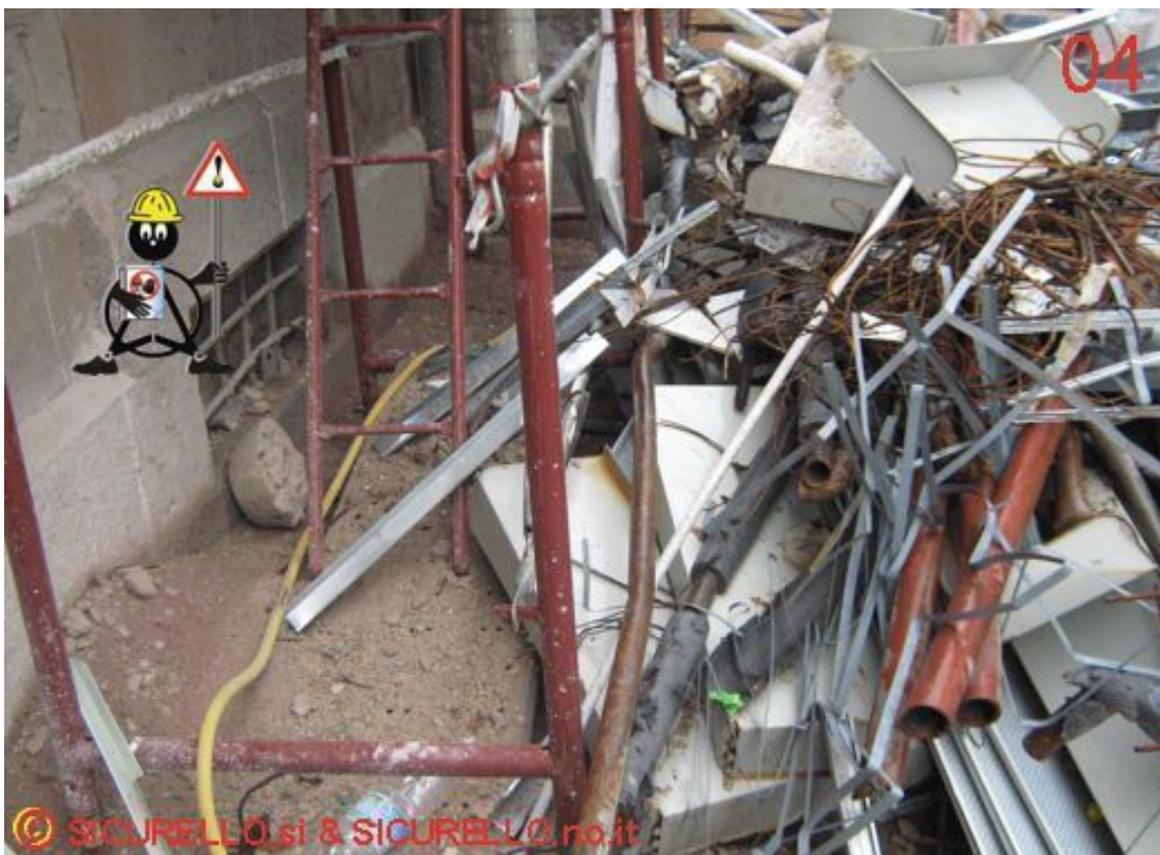
Foto 04: La base del ponteggio diventa una discarica. Vi è rischio che la base del ponteggio venga danneggiata durante le fasi di accatastamento e/o rimozione del materiale ed anche il rischio di danni agli operatori che utilizzano la scaletta di accesso al ponteggio.
