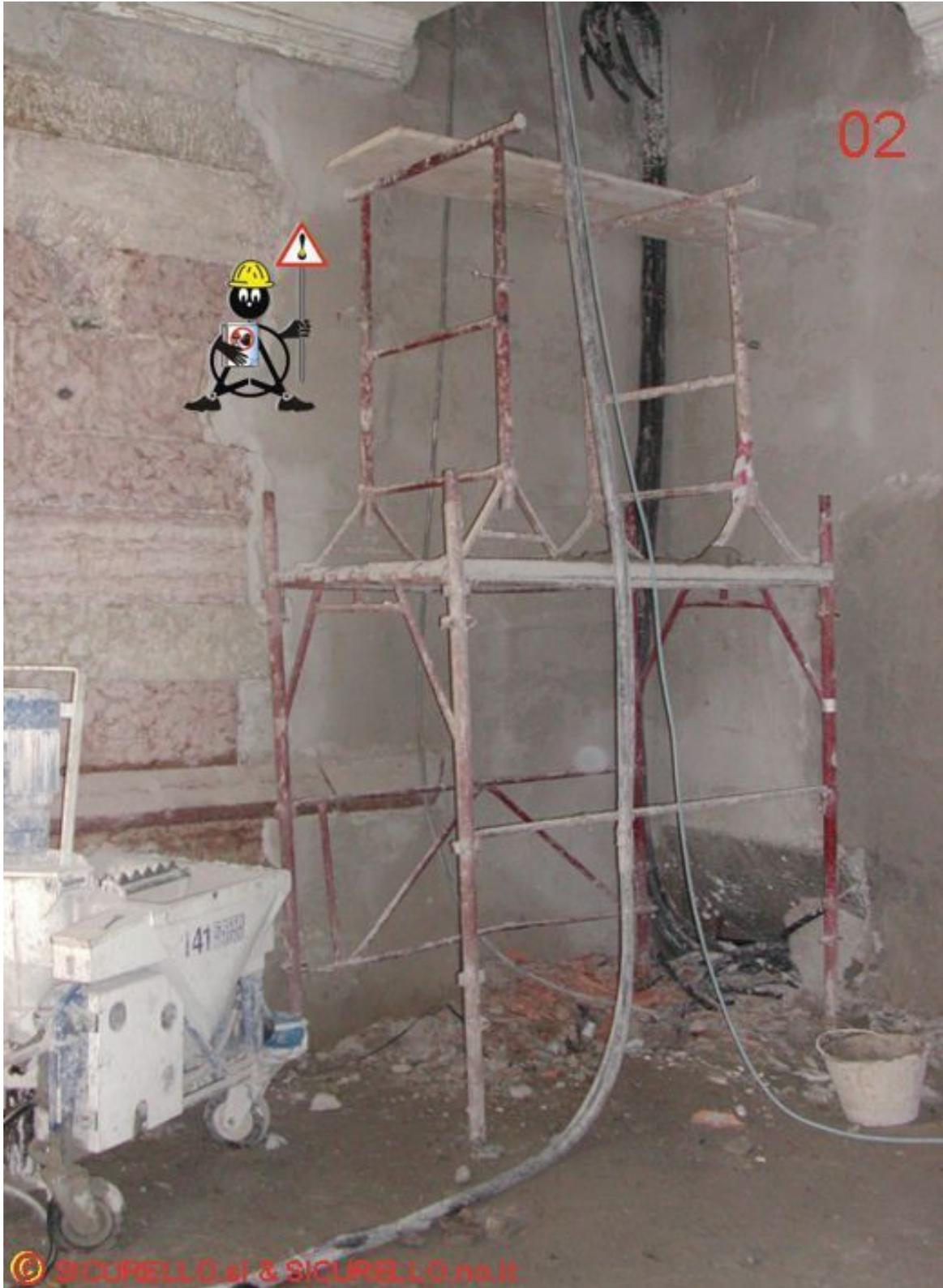
Foto 02: Al ponte a telai prefabbricati è stato sovrapposto un ponte su cavalletti. Un'insieme instabile.
