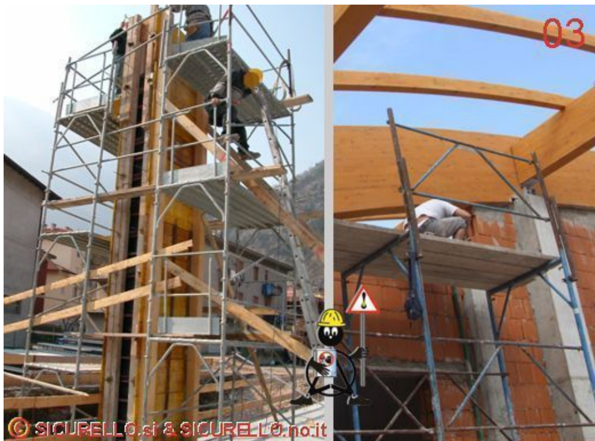
Foto 02: Due le situazioni evidenziate, nella prima l'operaio si posiziona tra il ponteggio ed il parapetto del poggiatesta attiguo. In caso di caduta il salto è di una decina di metri. Nella seconda un operaio lavora su un ponte realizzato con cavalletti ed il parapetto del poggiatesta non lo tutela dal rischio di caduta.
