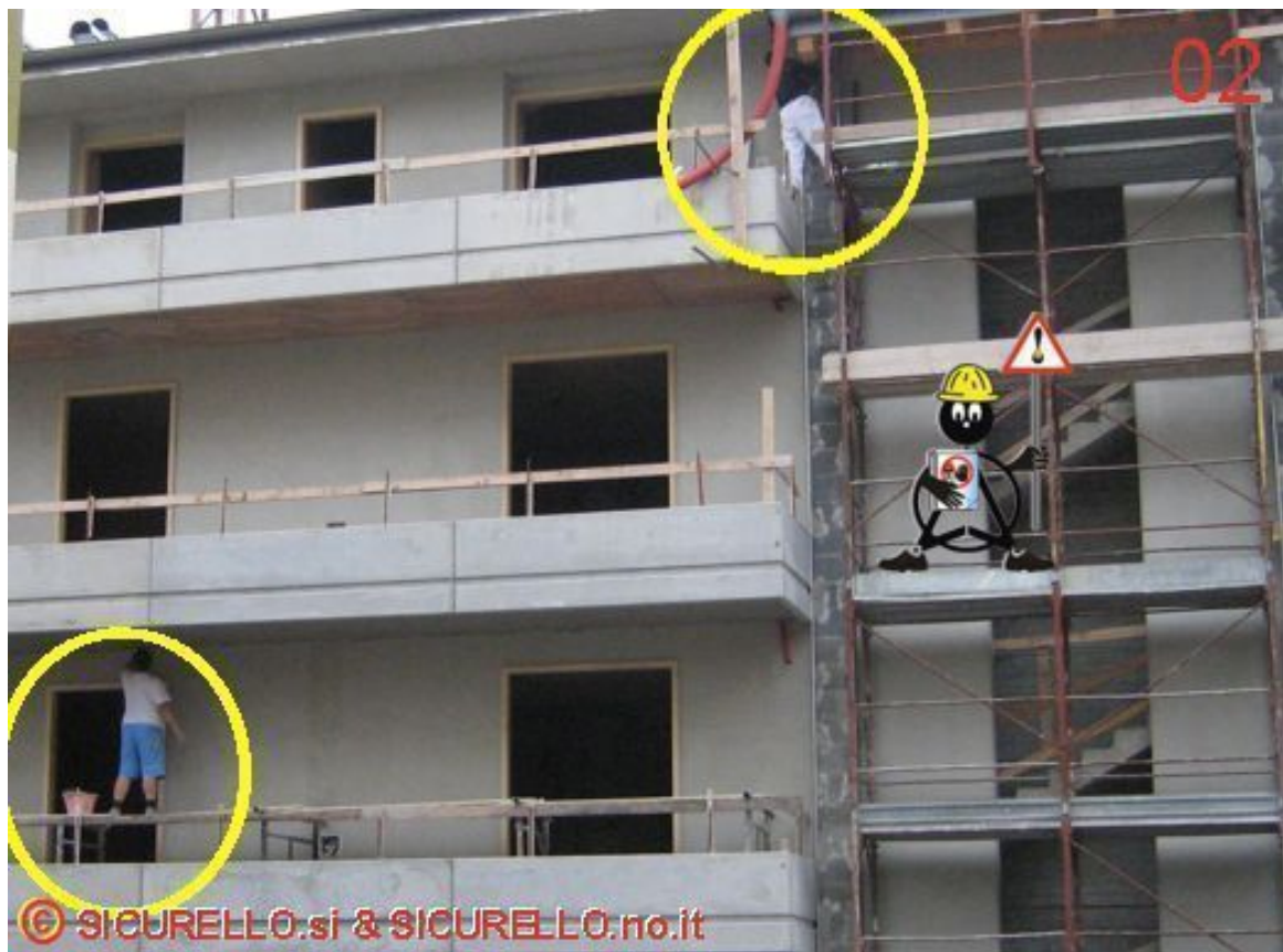
Foto 02: Due le situazioni evidenziate, nella prima l'operaio si posiziona tra il ponteggio ed il parapetto del poggiatesta attiguo. In caso di caduta il salto è di una decina di metri. Nella seconda un operaio lavora su un ponte realizzato con cavalletti ed il parapetto del poggiatesta non lo tutela dal rischio di caduta.
