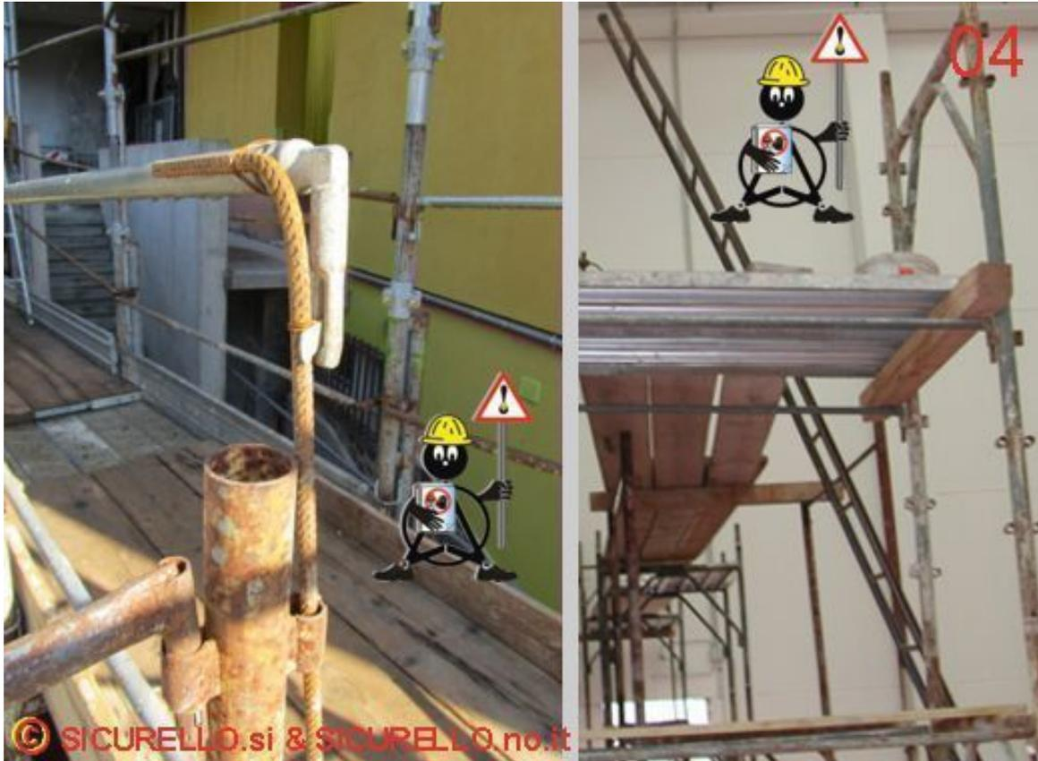
Foto 05 lato sinistro: Il ponteggio è insufficiente per raggiungere l'area di lavoro ed allora viene integrato con un piano aggiuntivo realizzato con cavalletti estensibili. Il rischio di caduta dall'alto è più che evidente.
