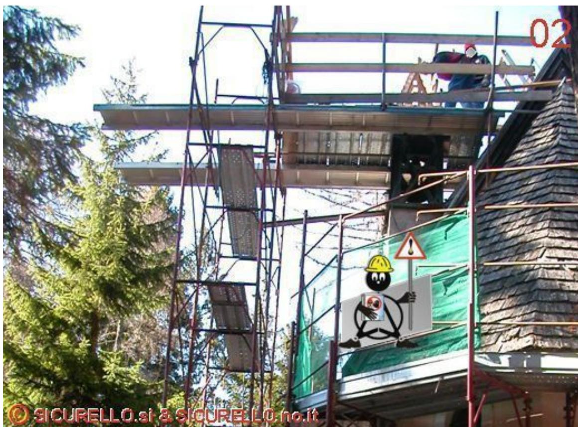
Foto 03: Il diagonale di un ponteggio viene utilizzato come corrente per la formazione di un parapetto. E se le misure non sono corrispondono: filo di ferro a volontà.
