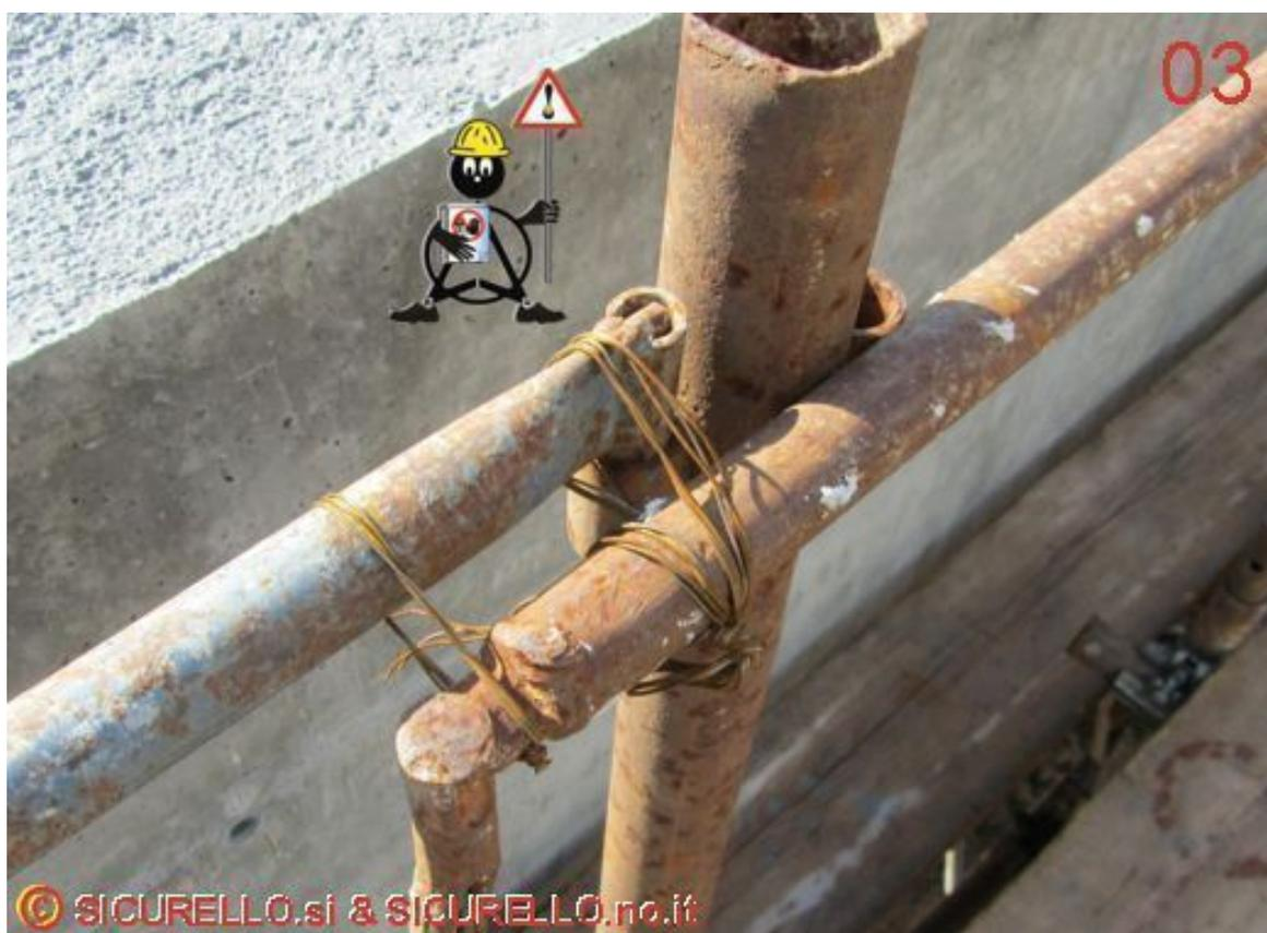
Foto 04 lato sinistro: Elementi di ponteggio "adattabili". Anziché approntare il ponteggio con l'utilizzo di tubi e giunti, oltre al "filo di ferro" sono stati utilizzati anche "tondini di armatura".
