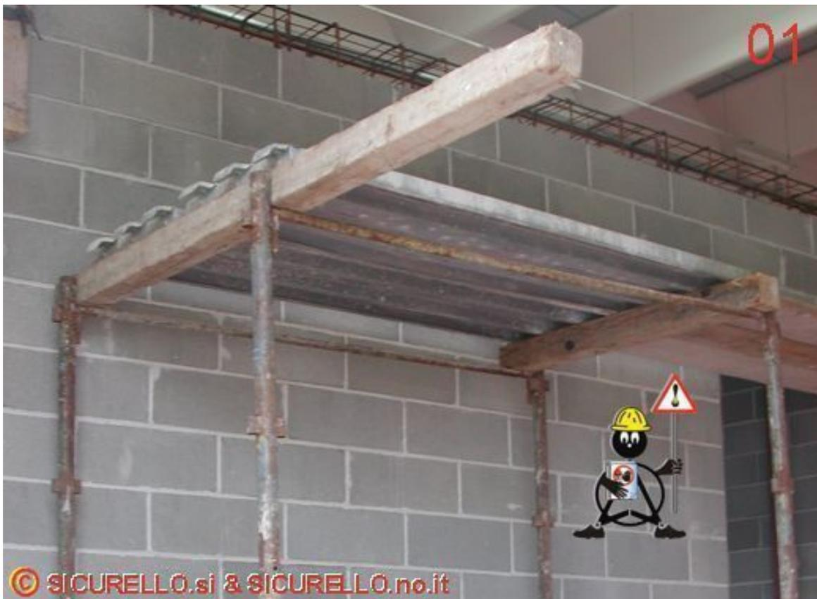
Foto 02: E' stato creato un piano di lavoro in quota assemblando elementi di ponteggio ad altre strutture. Il risultato è definibile come "il classico castello di carte".
