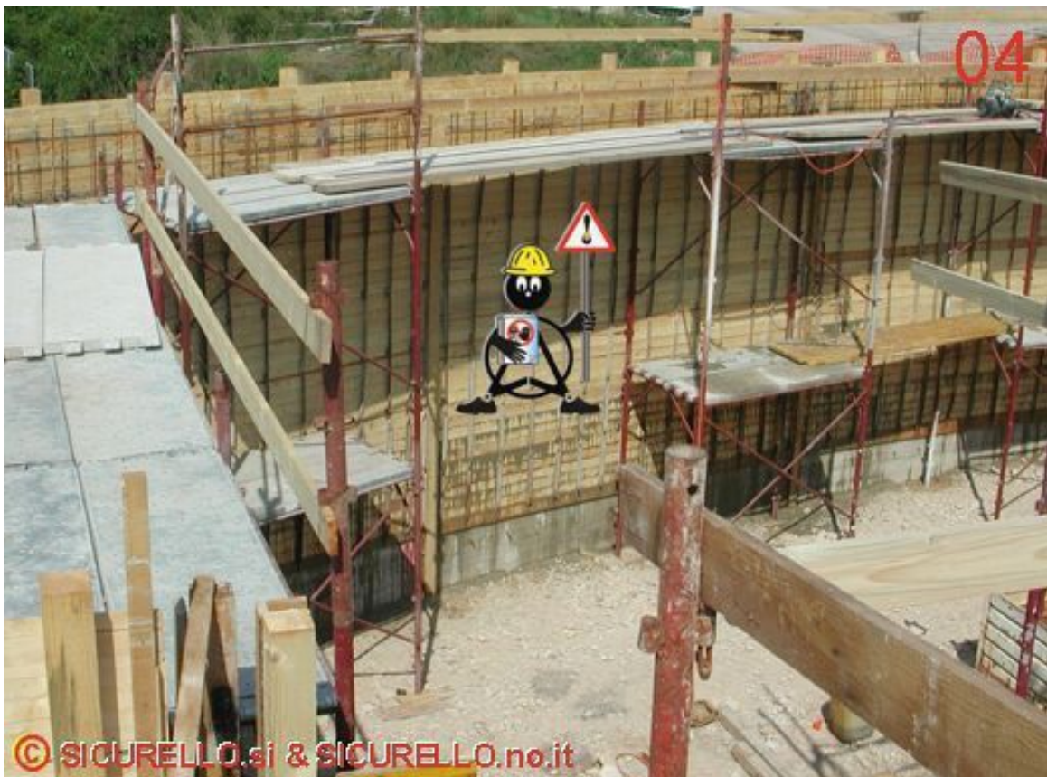
Foto 04: parapetti e piani di lavoro incompleti. Foto 05 lato destro: parapetto incompleto. Foto 04 e 05 lato destro: mancanza del sottoponte di sicurezza che, ricordiamo, deve essere realizzato ad una distanza massima di ml. 2.50 dal piano di lavoro e costruito come il ponte stesso. Il sottoponte può essere omesso per lavori di manutenzione o di riparazione di durata inferiore a 5 giorni.
