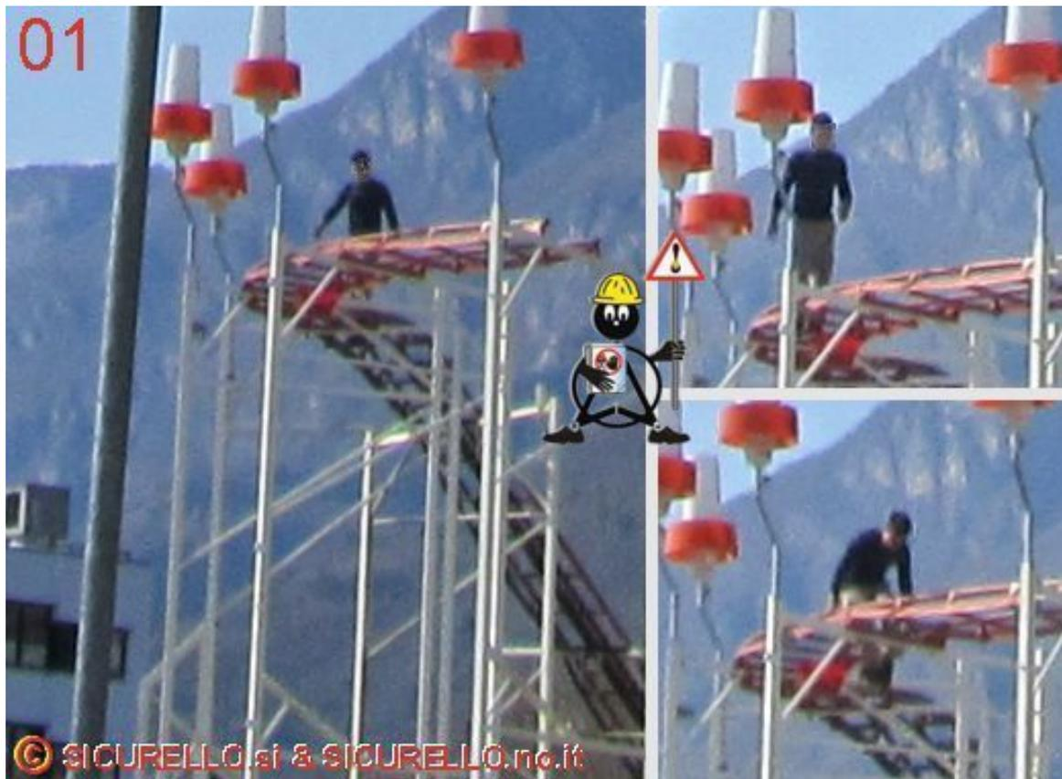
Fermandosi a guardare cosa succede si rimane sbigottiti: il lavoratore che sale lungo il binario come se fosse una normale scala, il posizionamento tra le traversine, l'aggancio della struttura alle catene, la rimozione dei fermi e lo sgancio di parte della medesima struttura ed altre "manovre similari" comportano decine di situazioni a rischio infortunio.
