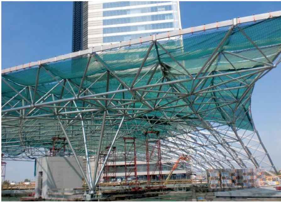
Inoltre queste reti di sicurezza S "devono avere una superficie minima di 35 mq e lato corto non inferiore a 5 m. Per quelle di dimensioni inferiori (non previste nelle norme UNI EN 1263-1) e che vengono spesso utilizzate è il fabbricante che deve fornire una specifica tecnica nella quale sono evidenziati i rischi che la stessa è in grado di eliminare e/o ridurre e le condizioni di utilizzo".
