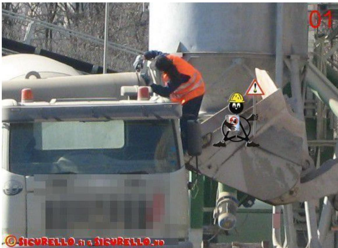
I **rischi** sono gli stessi già analizzati la volta scorsa (caduta dall'alto, cesoiamento tra la benna ed il camion), inoltre è da rilevare come anche il rischio di danneggiamento della cabina del mezzo sia molto elevato.
