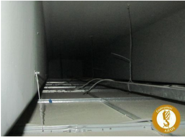
Figura 1 ? Esempio di pendinatura irregolare di un controsoffitto effettuata con normale filo di ferro ritorto ed ancoraggi a parete e soffitto realizzati con vili e tasselli non idonei.
