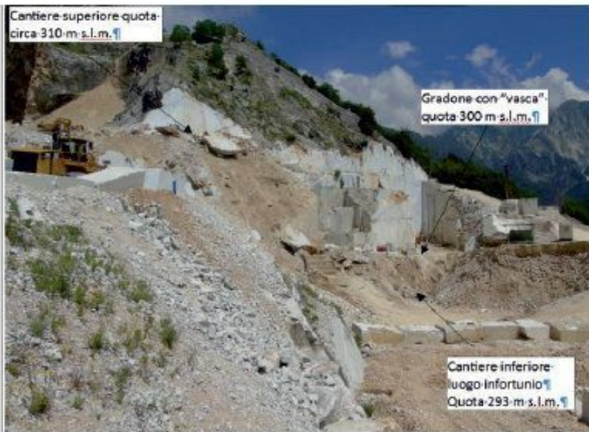
Foto 3 - distribuzione dei cantieri
