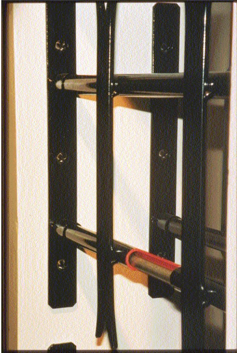
La seconda fotografia fa riferimento ad una inferriata, anch'essa realizzata con tubazioni, all'interno delle quali scorre una fibra ottica di tipo economico, in quanto non trasmette dati, ma solo radiazioni luminose. Da un lato vi è una sorgente di luce e all'altro estremo viene un rivelatore. Se, durante l'attacco, i malviventi interrompono la fibra ottica, si lancia un allarme.
