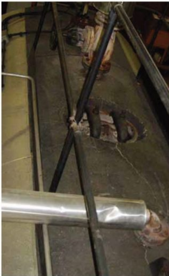
(Figura 3 - passo d'uomo 32x42 generatore di vapore a tubi di fumo da 3 l/ora)
