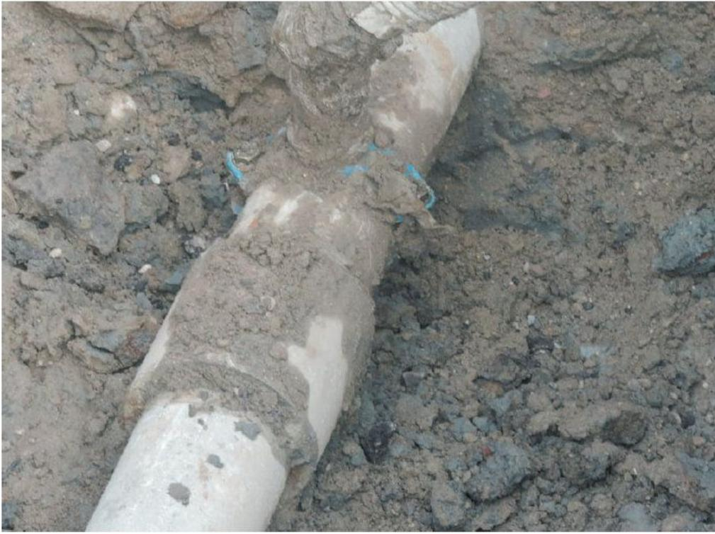
Immagine: Terreno contaminato intorno a tubazione in cemento-amianto ammalorata
