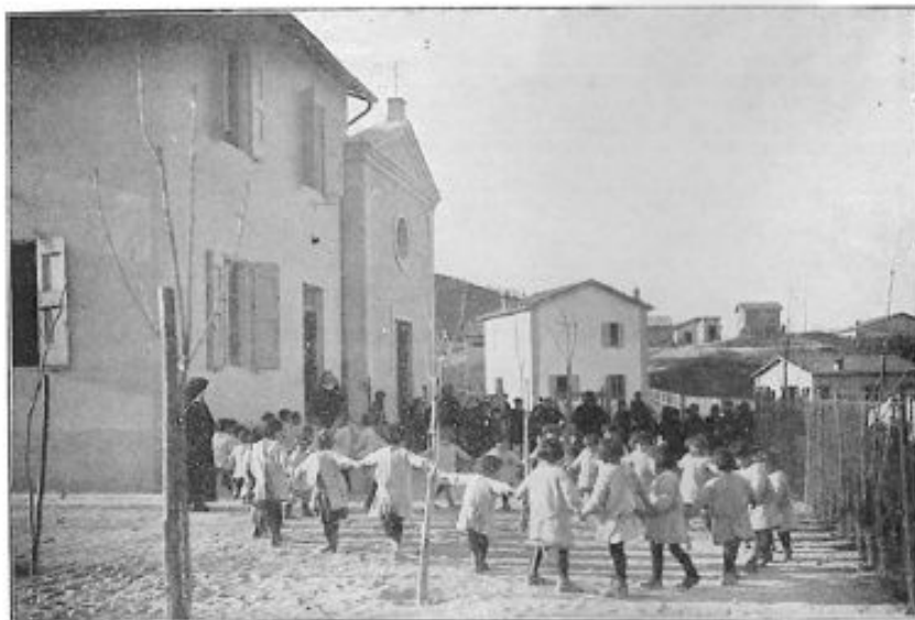
CANTIERE DI LAGARO (IMBOCO NORD) - SCUOLA, ARTO E CHIESA.
