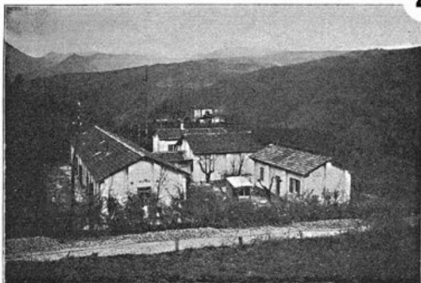
OSPEDALETTO DEL CANTIERE DI LAGORO.
