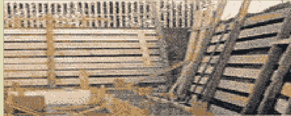
Gli scavi in trincea vanno poi attrezzati con scale a pioli, ancorate stabilmente per consentire agli operatori di lavorare in sicurezza e di risalire agevolmente in caso di pericolo. I bordi dello scavo devono essere protetti da bordi rialzati di almeno 30 cm sul piano di campagna.
