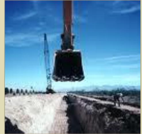
Realizzazione di uno scavo meccanico in un terreno argilloso per le fondazioni di un edificio
