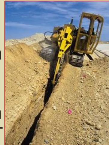
Recentemente sono state immesse sul mercato macchine per lo scavo parallelepipedale a sezione obbligata che consentono di scavare le dimensioni minime necessarie.
