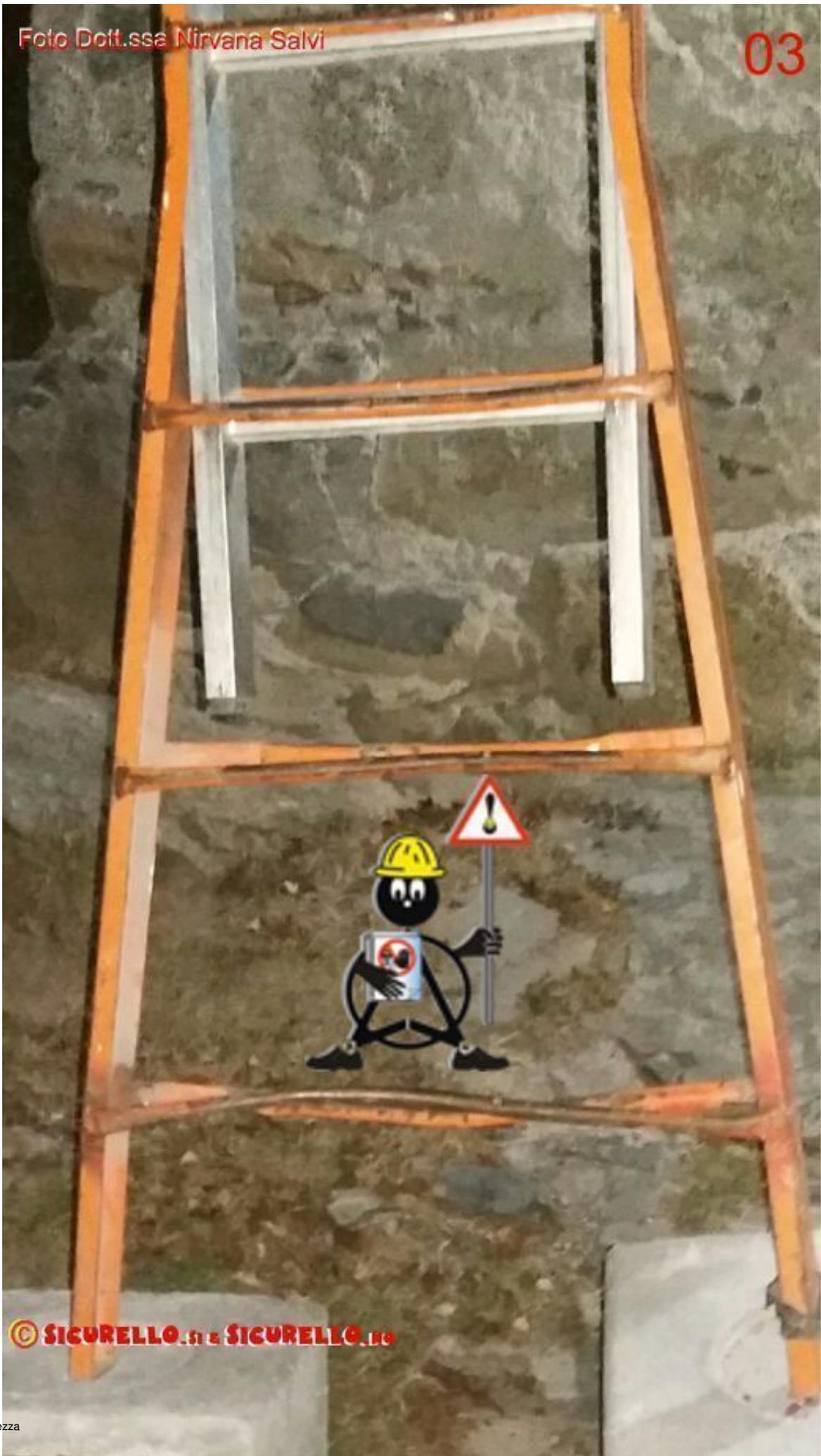
Alcuni laterizi, un paio di pozzetti in cemento *et voilà* la base di partenza della scala portatile è predisposta. E come se non bastasse anche la scala non è certamente nelle migliori condizioni di manutenzione.
