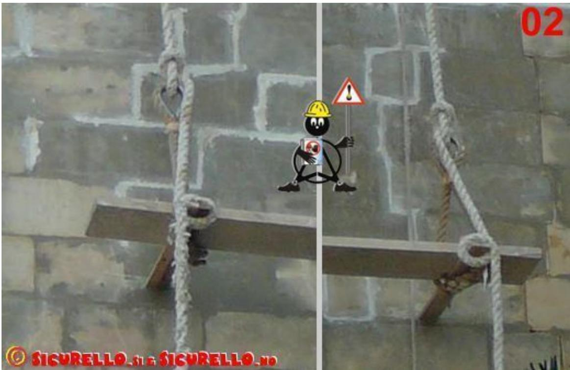
Ed è così che partendo dall'alto, dopo aver passato due corde in altrettanti fori maldestramente realizzati sulla muratura, l'operaio si cala pian piano verso il basso rilasciando gradatamente le cime che sostengono l'improbabile ed insicuro "ponte sollevabile".
