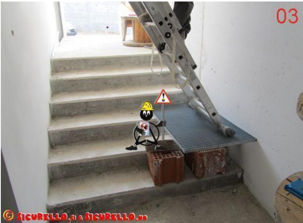
Scale posizionate su pianerottoli (od altre scale in muratura/acciaio) con il lavoratore che per eseguire la manutenzione supererà la quota del parapetto presente e di conseguenza, in caso di caduta, il rischio di precipitare nel vuoto, magari in presenza di notevoli altezze, può portare ad infortuni di elevata gravità
