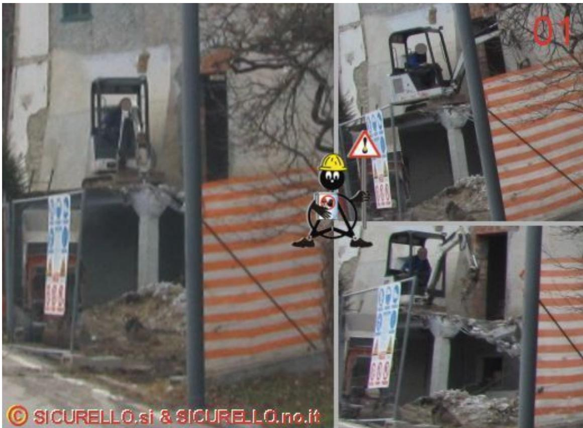
Ed invece non si tratta di comiche, ma di un'attività di demolizione di una struttura in cemento armato dove l'operatore si posiziona, con il minimezzo meccanico dotato di martellone, direttamente sulla struttura da demolire.
