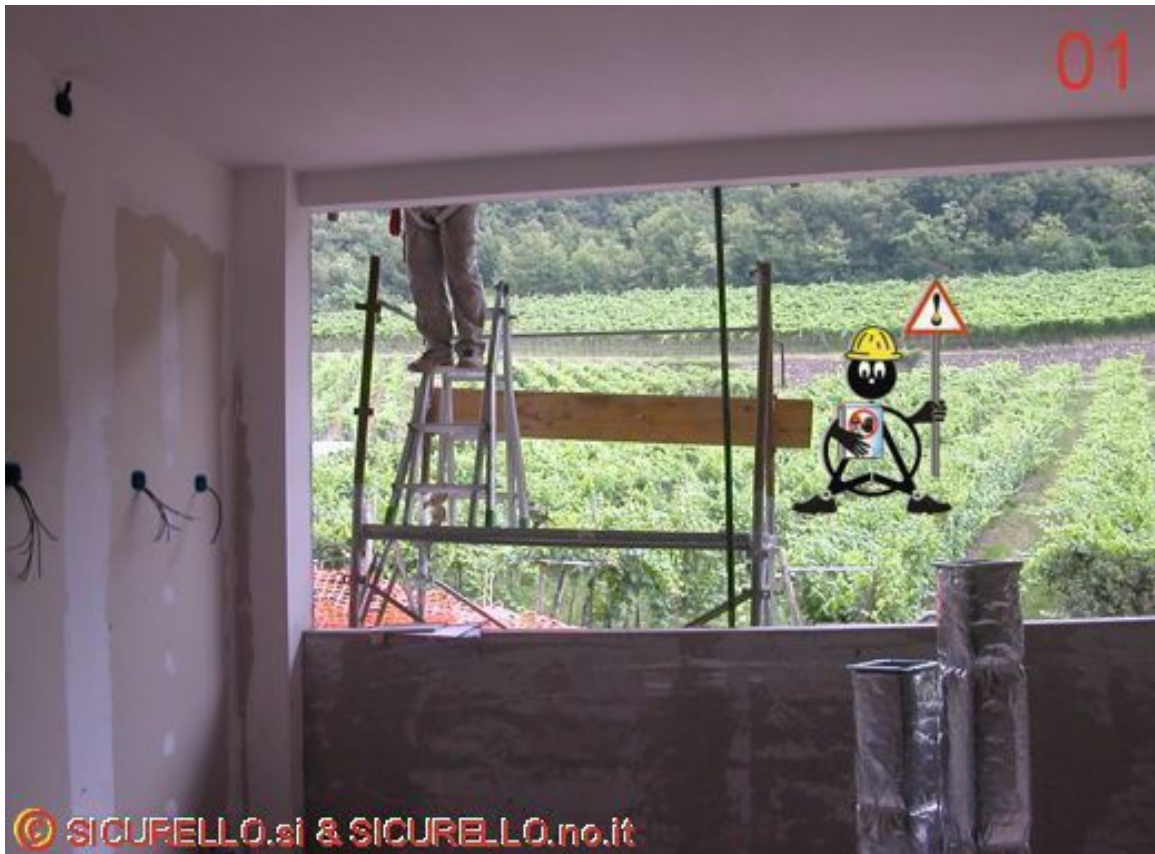
Foto 01: Il ponteggio , incompleto e precario, viene utilizzato come base di partenza per posizionare una scala doppia.
