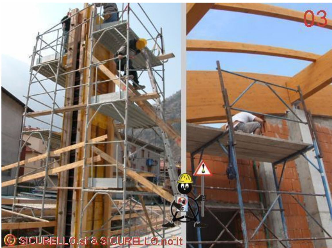
Foto 02: Due le situazioni evidenziate, nella prima l'operaio si posiziona tra il ponteggio ed il parapetto del poggiolo attiguo. In caso di caduta il salto è di una decina di metri. Nella seconda un operaio lavora su un ponte realizzato con cavalletti ed il parapetto del poggiolo non lo tutela dal rischio di caduta.
