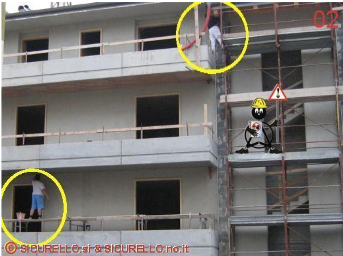
Foto 02: Due le situazioni evidenziate, nella prima l'operaio si posiziona tra il ponteggio ed il parapetto del poggiolo attiguo. In caso di caduta il salto è di una decina di metri. Nella seconda un operaio lavora su un ponte realizzato con cavalletti ed il parapetto del poggiolo non lo tutela dal rischio di caduta.
