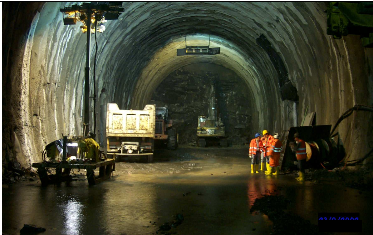
Fig.1: caricamento della volata – l'illuminazione è ottenuta con fari alogeni 150W-24V autoalimentati montati sul carro monte
